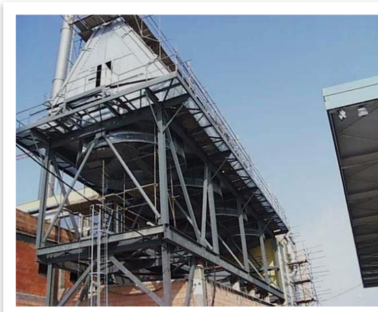
Akustická zástěna vzduchových kondenzátorů s tlumeným přísáváním (před a po instalaci).
