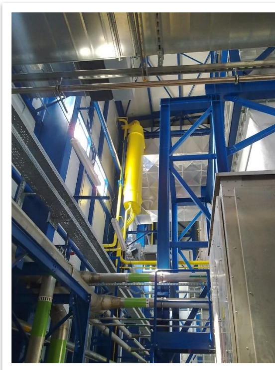
Tlumič odvodu zemního plynu z propojovacího potrubí kompresor – turbína. Sdružený tlumič odvodu pro vícero vstupů, Bratislava, Slovenská republika.
