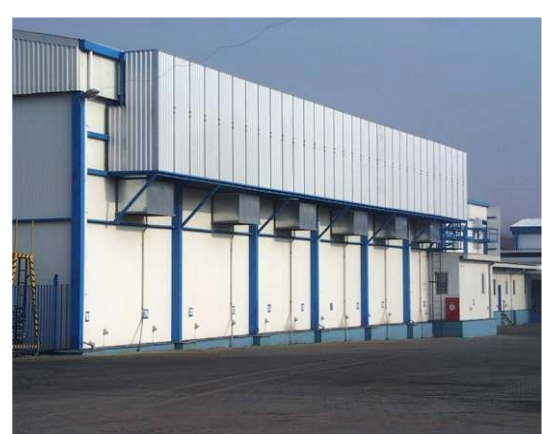
Akustická zástěna vzduchových kondenzátorů s tlumeným přísáváním (před a po instalaci).
